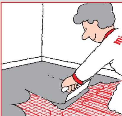
Поверх кабелей укладывается и разглаживается слой 3130 superfix или 3250 superplanfix, так, чтобы полностью их покрыть.
